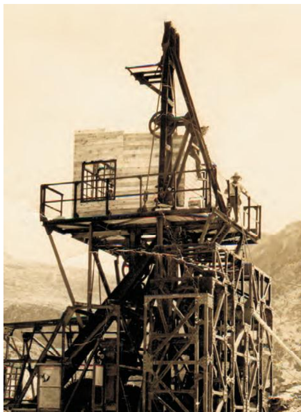
Fotografía: Construcción del Embalse del Aguascebas (posiblemente 1954). Archivo Fernando Cano
