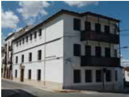
La casa-convento de Villacarrillo, en las confluencias de las calles Santa Ángela de la Cruz y Ramón García del Valle
